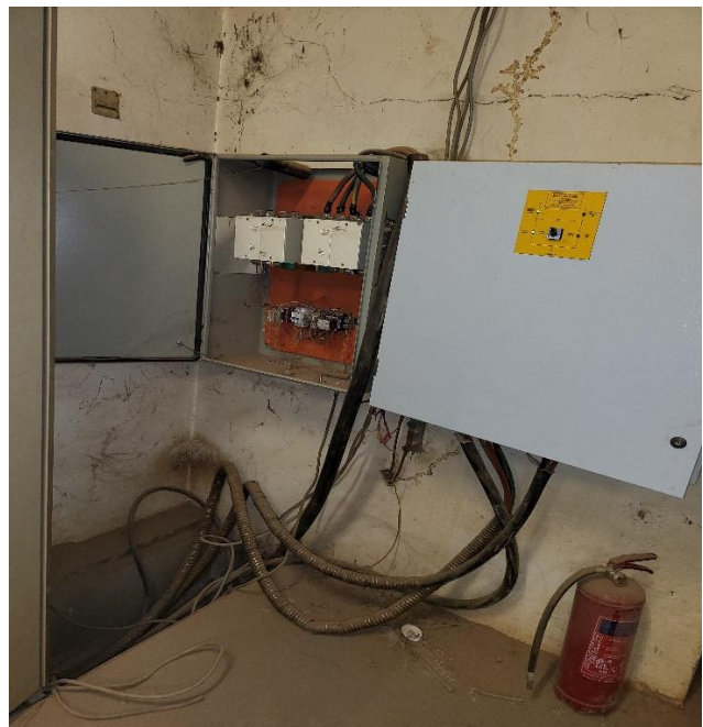
Départ du branchement au réseau usage ENS/CEA
