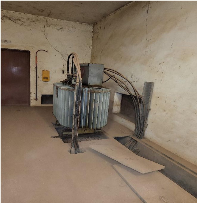
Transformateur MT et sortie au compteur de fourniture d'électricité.
