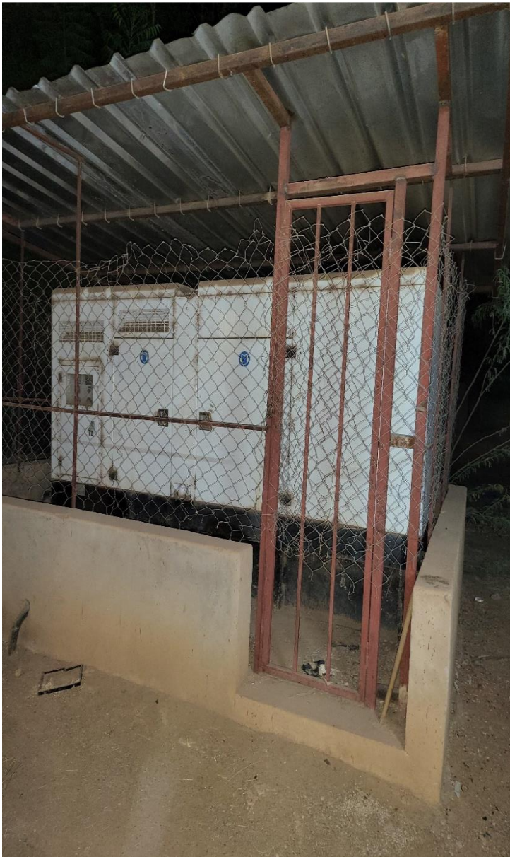
Un des 2 groupes électrogène servant de fourniture de courant en cas de coupure du réseau de courant du réseau NIGELEC (Société Nigérienne d'électricité)
