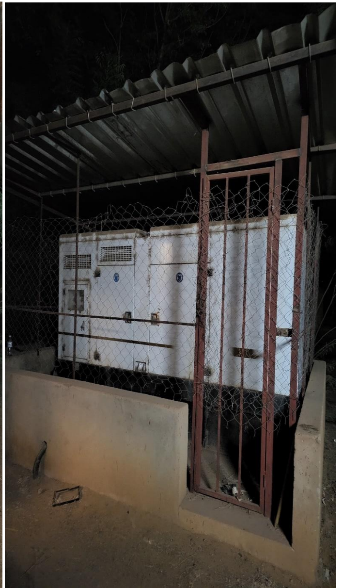
Un des 2 groupes électrogène servant de fourniture de courant en cas de coupure du réseau de courant du réseau NIGELEC (Société Nigérienne d'électricité)
