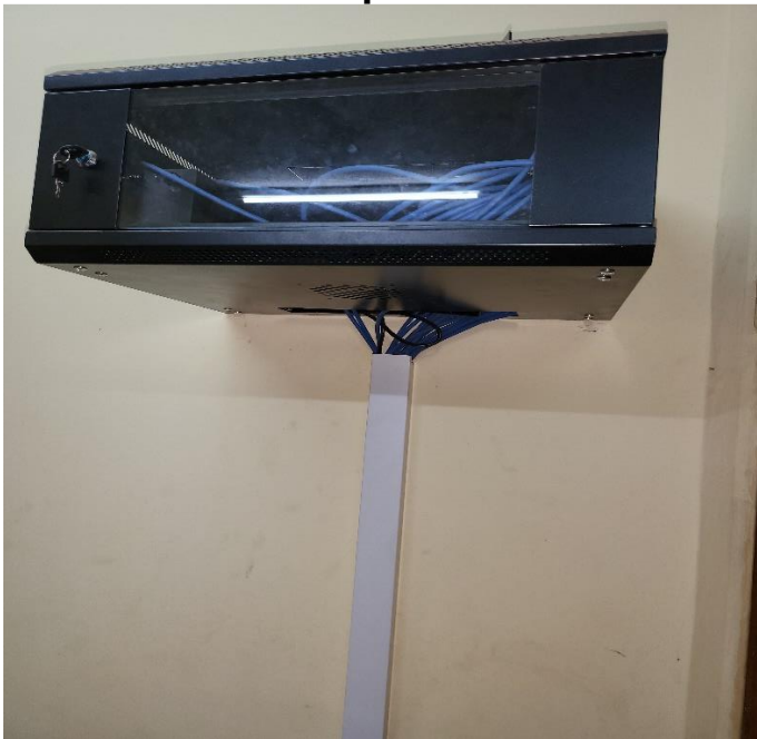
Switch et câblage pour connexion internet.
