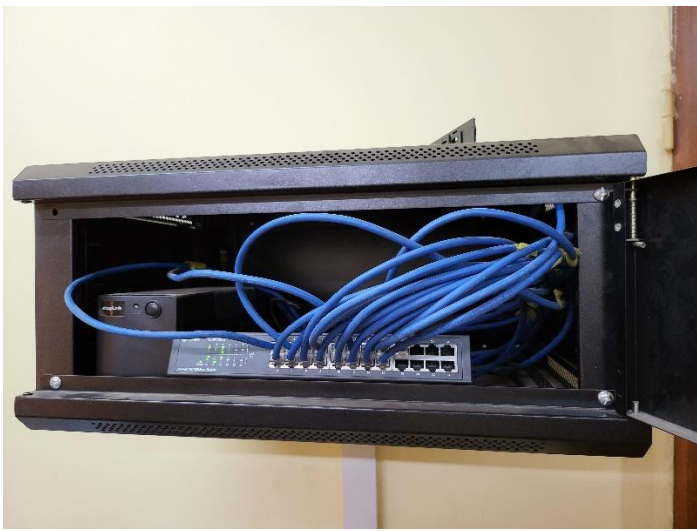
Switch et coffrets pour connexion internet.
